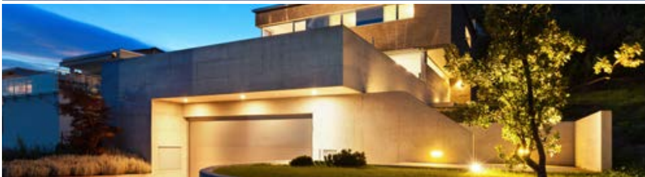
ELECTRICIDAD Y TELECOMUNICACIONES
